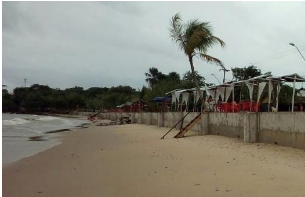
Figura 7. Muro de contenção construído na praia do Marahú.
