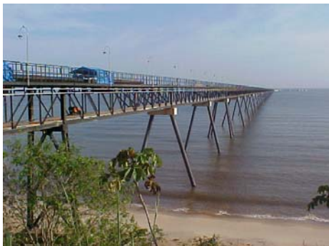
(a) Vista lateral do ponto de vista da área retro-portuária
