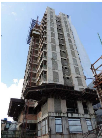
Figura 1 – Vista geral do edifício analisado.
