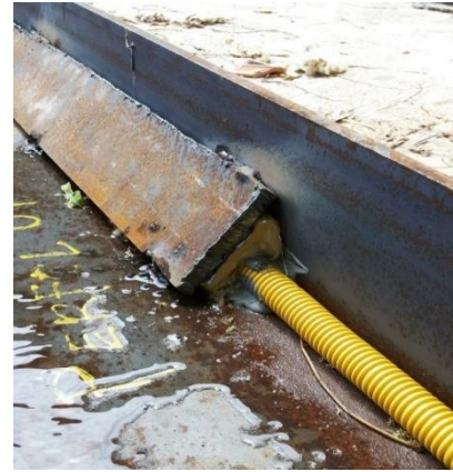
Figura 4 - Proteção dos cabos
