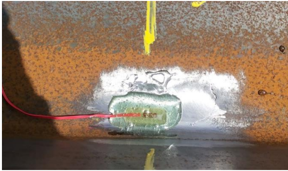
Figura 3 - Proteção dos sensores a prova d'água
