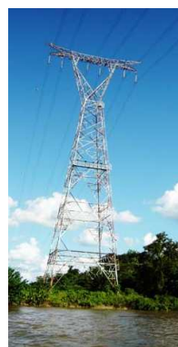
(a) Torre vista do rio Guamá
