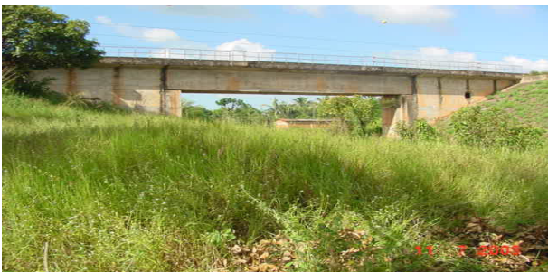
Fig. 12 Viaduto sobre a CFN 1 travessia [1]
