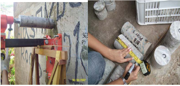
Fig. 3 Retirada de testemunhos de concreto [1]
