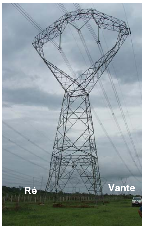
Figura 2 - Vista geral da torre
