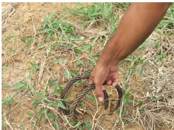
Figura 10 – Ancoragem dos estais
