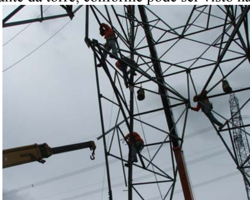
Figura 14 – Preparação para a retirada da “perna” danificada, liberação das ligações com o restante da torre
