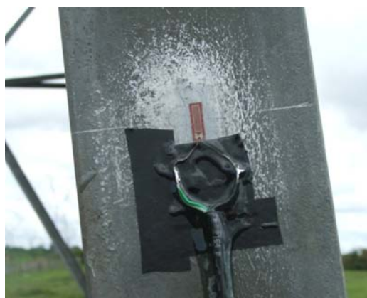
Figura 18 – Extensômetro fixado no montante
