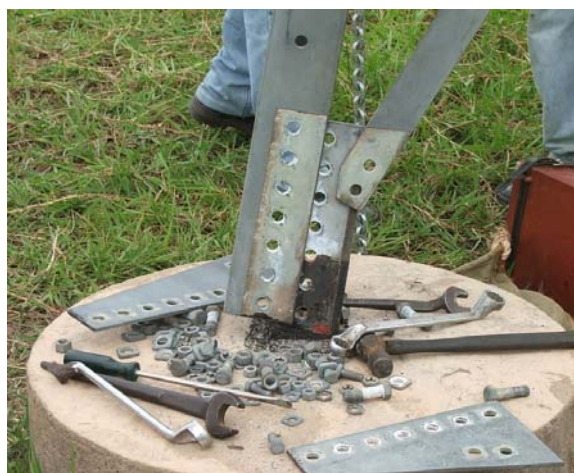
Figura 13 – Liberação da “perna da torre” com a fundação
