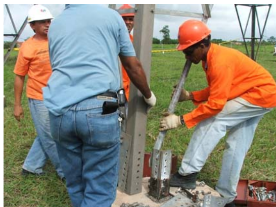
Figura 16 – Fixação da nova “perna” na torre Figura 17 – Fixação da nova “perna” na fundação
