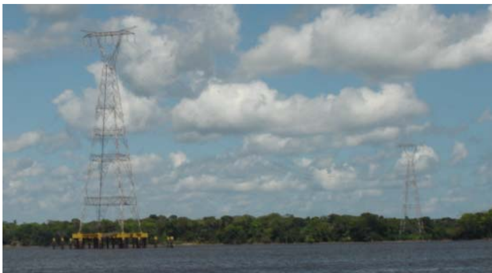
Figura 3 – Linha de transmissão Vila do Conde - Guamá
