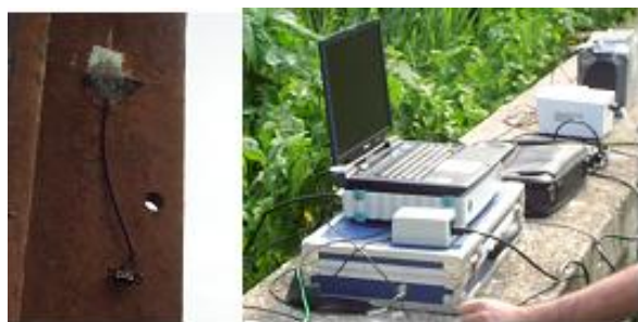
Figura 15 – Instrumentação dos montantes da torre com extensômetros elétricos de resistência ( strain gages )
