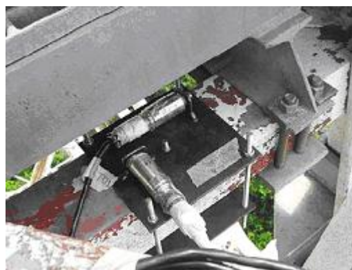
Figura 18 – Acelerômetros instalados nas posições A1 e A2.
