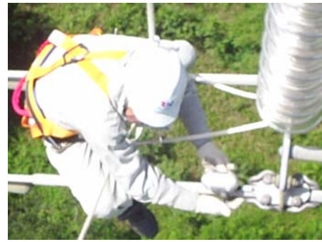
Figura 24 – Vibrógrafo Pavica sendo instalado em um cabo condutor do trecho de travessia em estudo.
