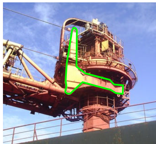
Figura 2 - Estrutura de suporte do elevador de caçambas do descarregador de navio (lado direito, face externa)
