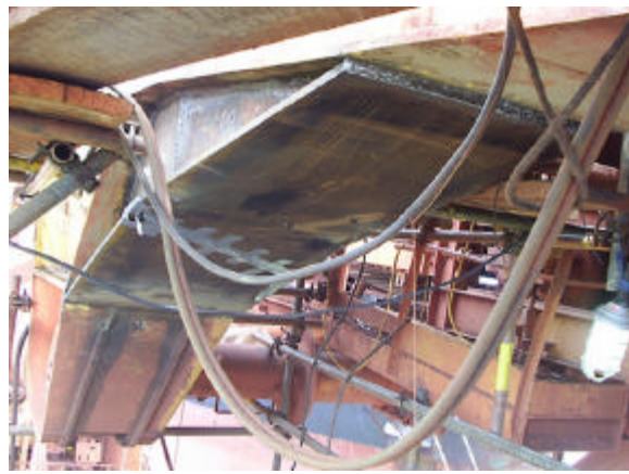
Figura 6 - Reforço construído na parte inferior da viga caixão
