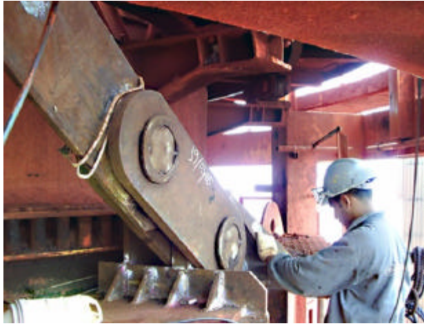
Figura 7 – Dispositivo tensor instalado na estrutura para alívio de tensões
