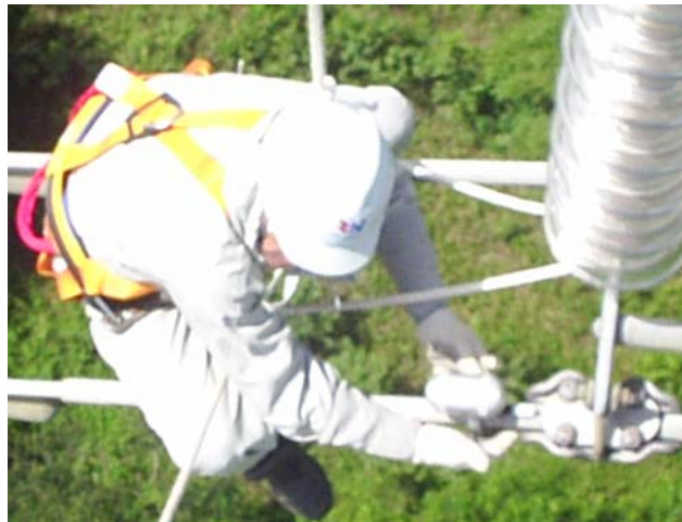
Figura 3 – PAVICA sendo instalado na linha do trecho Vila do Conde – Guamá.
