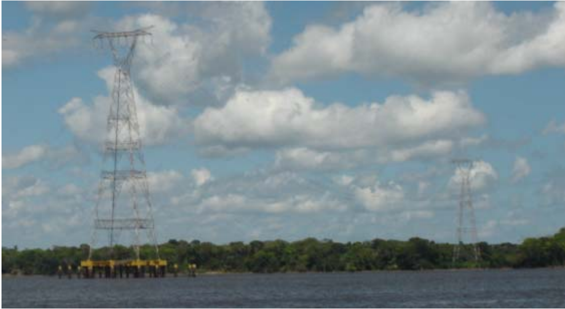
Figura 1- Trecho da Linha de Transmissão 230 kV Vila do Conde-Guamá
