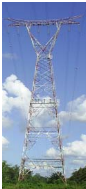
Figura 2- Torre 103 do vão da Linha de Transmissão 230 kV Vila do Conde-Guamá.
